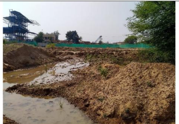
Fig. 10. ETP Effluent Overflow
