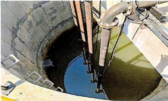
Plate: 5 : Effluent collection chamber
