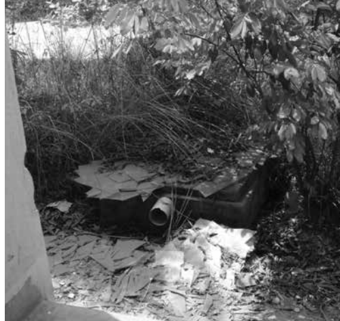
Broken conduit system
